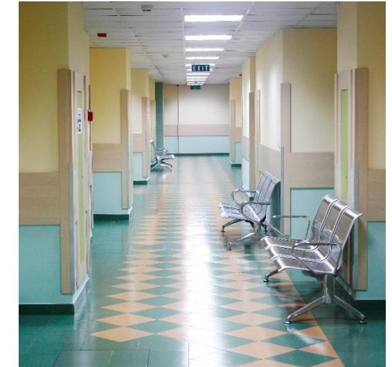
Minimalisir diskontinuitas/transisi lantai untuk mengurangi suara impact dari benda beroda.
